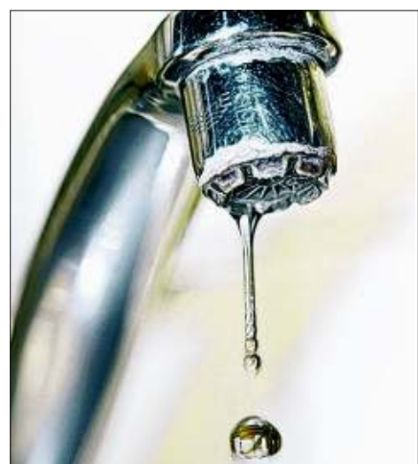
Essig löst zwar den Kalk am Wasserhahn, greift aber Dichtungen und Chrom an
